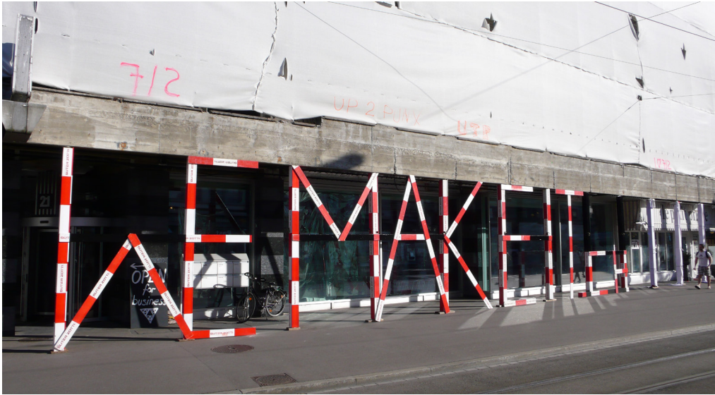
Baustellenästhetik: Gerüst mit wemakeit.ch, Zürich 2012 (Foto: Privataarchiv Michael Surber [p])
