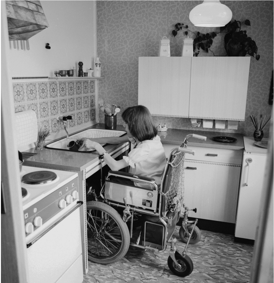
Unterfahrbare Spülbecken und niedriger gehängte Küchenschränke erleichterten Menschen im Rollstuhl die tägliche Hausarbeit, wie hier in einer Wohnung in Ost-Berlin (1979). (picture-alliance/ddrbildarchiv/Manfred Uhlenhut)
