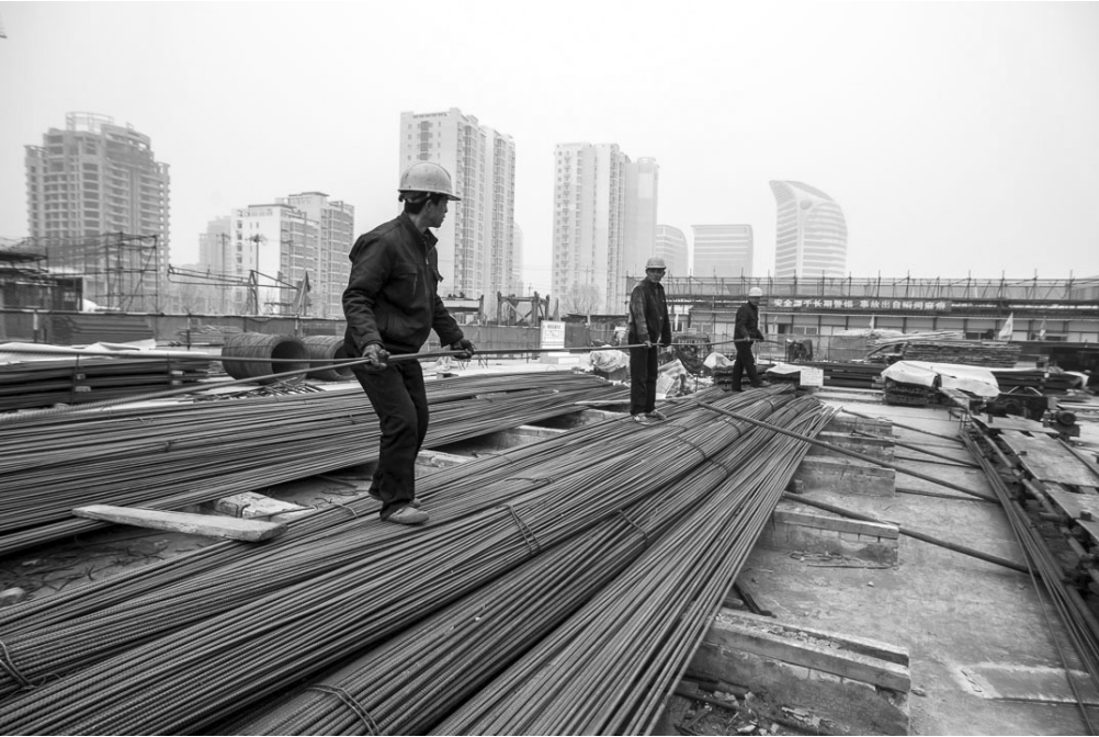
Wanderarbeiter auf einer Baustelle, Beijing, März 2013 (Flickr, Joe Tym/Ding Zhou, < https://www.flickr.com/photos/48135025@No6/8622393592 >, < https://creativecommons.org/licenses/by-nc-sa/2.0/ >)
