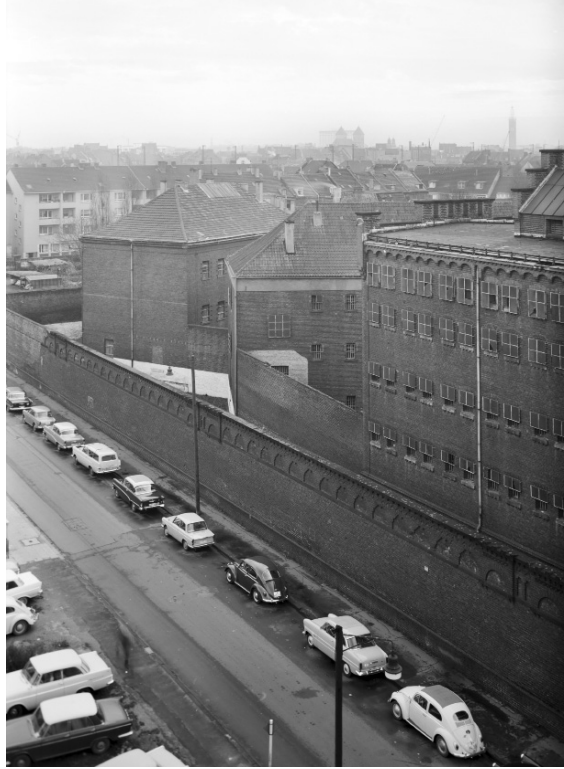
Gefängnis Klingelpütz, Köln (1834–1843 in zwei Bauphasen als preußisches Kriminalgefängnis errichtet, abgebrochen 1969 nach Fertigstellung der neuen Justizvollzugsanstalt Köln-Ossendorf) (© Rheinisches Bildarchiv Köln, Foto von 1963, rba_113520)
