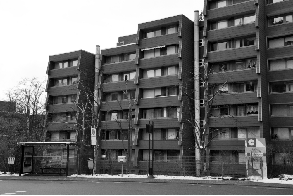
Modernes Bauen, ein ambivalentes Versprechen: Häuser am Mombertplatz im Heidelberger Stadtteil Emmertsgrund (Foto von 2013) (Wikimedia Commons/Foto: Christopher Jelen; Lizenz: CC BY-SA 3.0)
