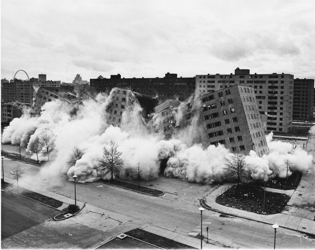
Abriss der US-amerikanischen Hochhaussiedlung Pruitt-Igoe, St. Louis, Mitte der 1970er-Jahre (Foto: United States Department of Urban Development; < http://commons.wikimedia.org/wiki/File:Pruitt-Igoe-collapses.jpg >)
