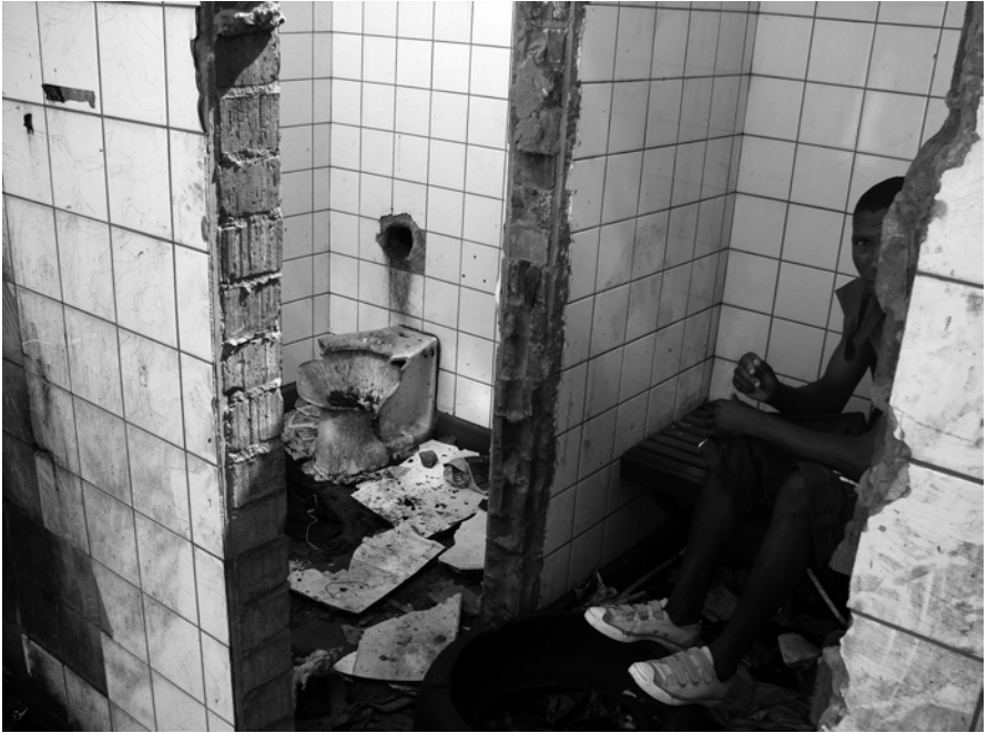
Bad Building in der Innenstadt von Durban – eines der Gebäude, welches durch die „Better Buildings Initiative“ kürzlich abgerissen wurde. (Better Buildings Initiative, Durban)
